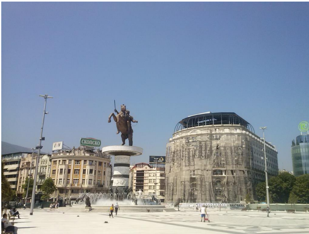
Glavni trg s kipom Aleksandra Velikega. Zraven seveda obnavljajo stavbo.
